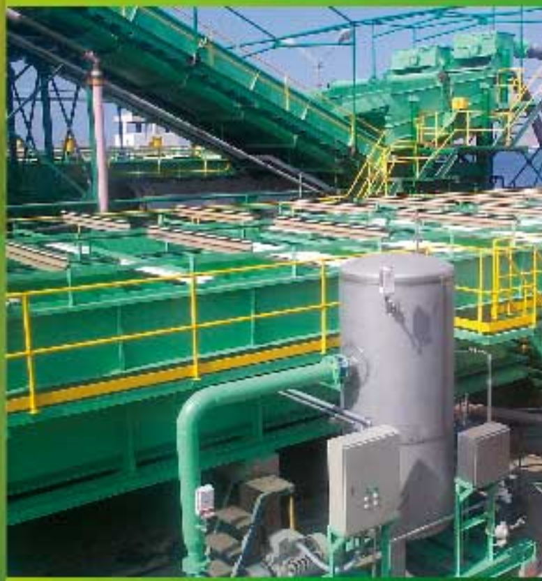
Instalación del Sistema DAF en Pisco
