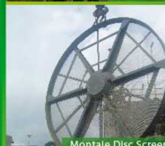
Montaje Disc Screen
